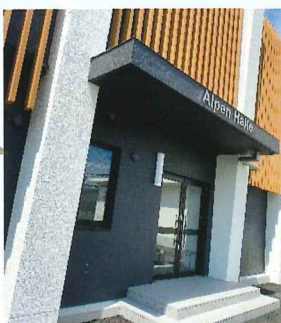
アルペンホール
